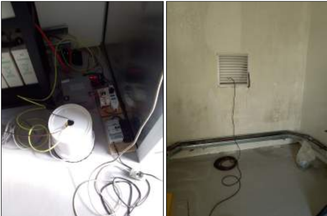
Figura 3. Instalación de la estación TCOA1 . A la izquierda, el sensor junto al armado de suministro de energía y cobertura wifi. A la derecha, instalación de la antena GPS por fuera del edificio.
