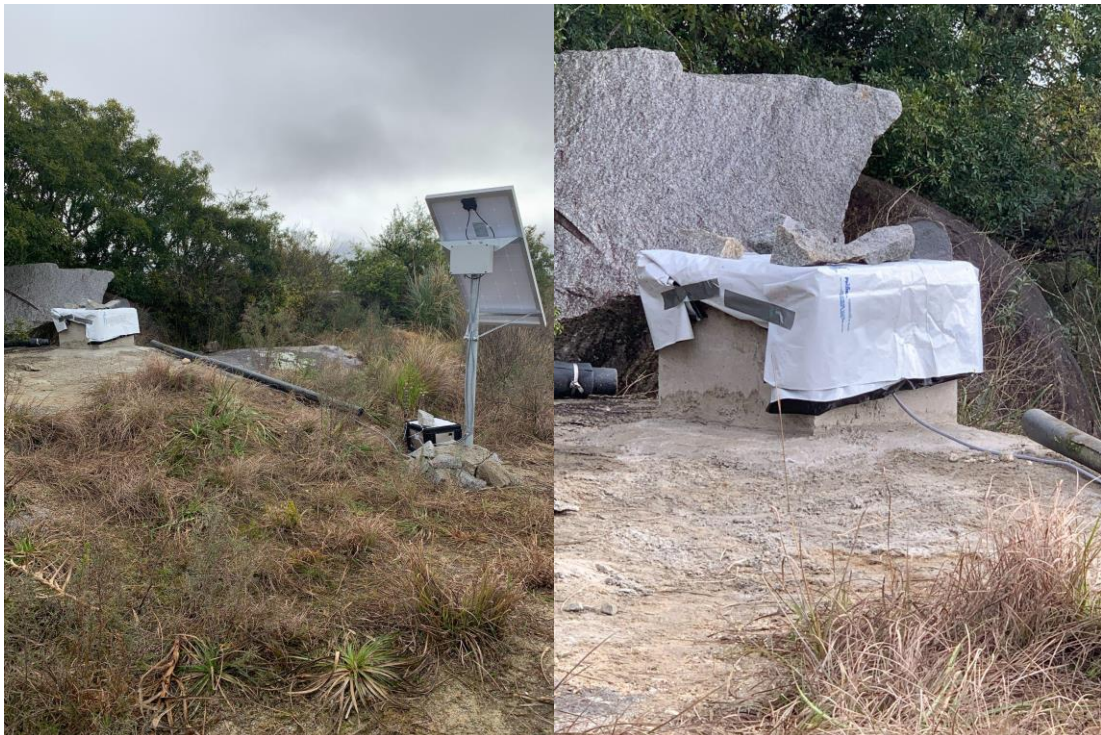
Figura 1. Nicho con sismómetros instalados alimentados con panel solar.
